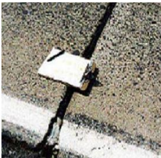
Figura 21 - Exemplo de escalonamento ou degrau nas juntas
