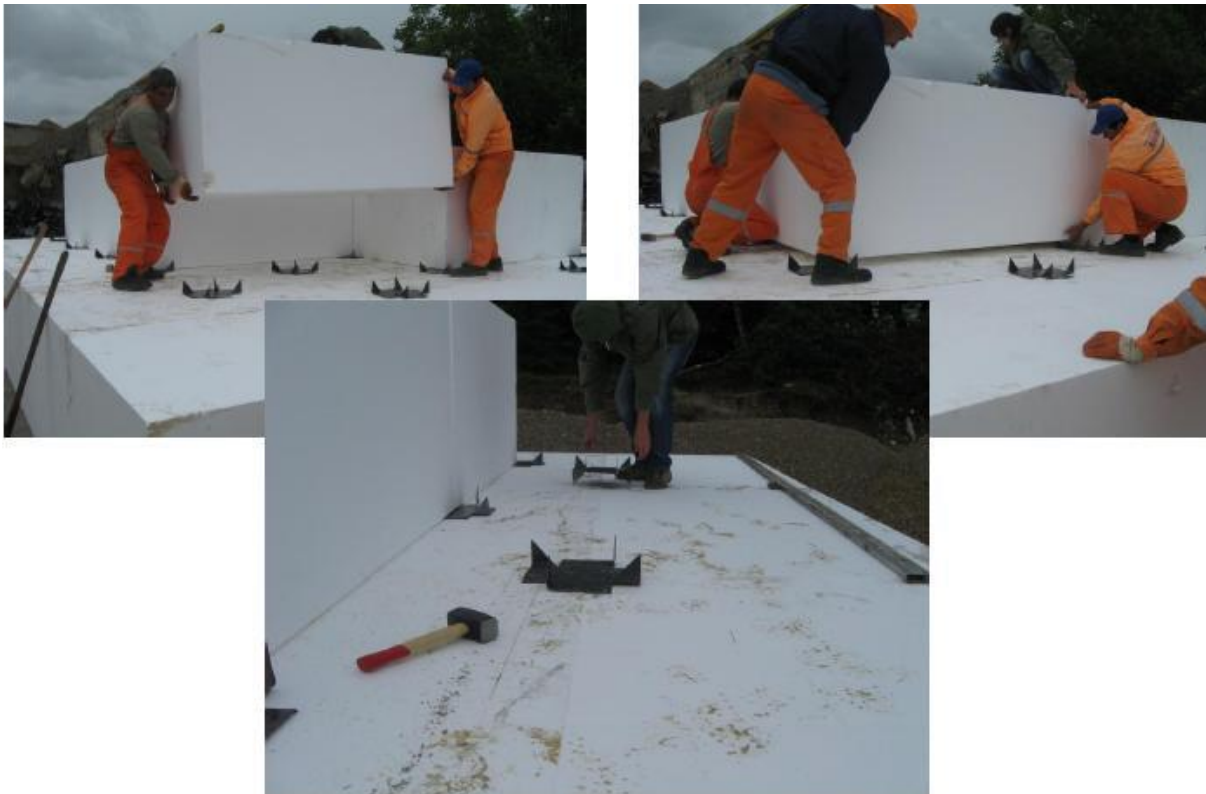
Figura 35 - Chapas dentadas usadas para aumentar a resistência ao cisalhamento entre blocos de EPS
