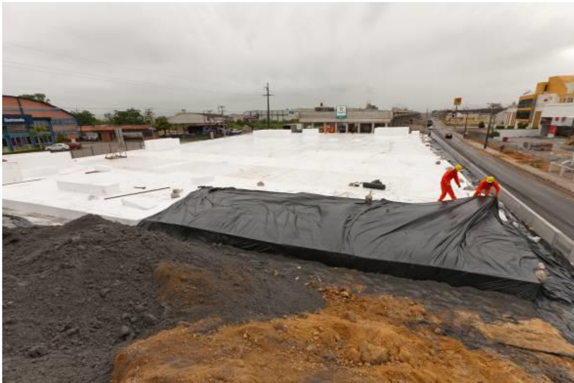
Figura 40 - Proteção do geoexpandido com geomembrana
