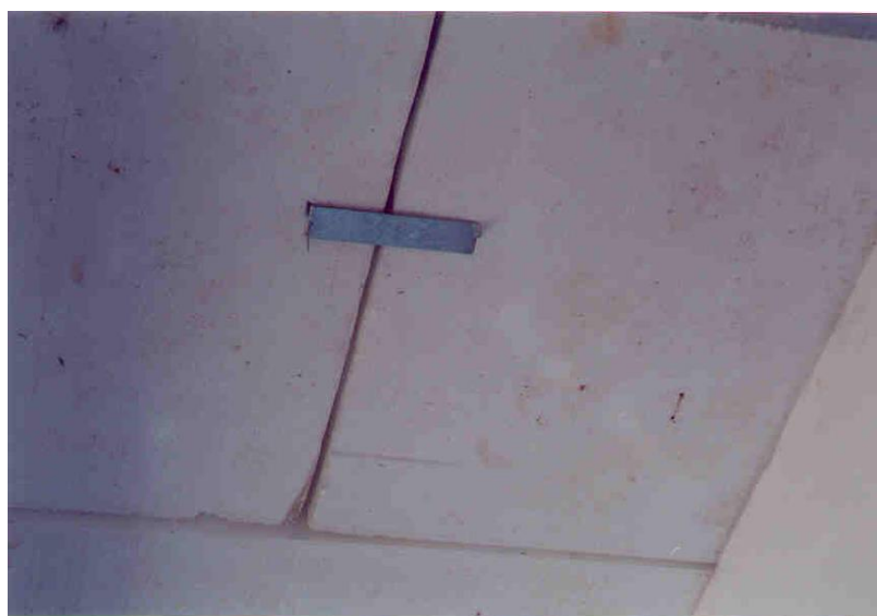
Figura 34 - Grampo usado para aumentar a resistência ao cisalhamento entre blocos de EPS
