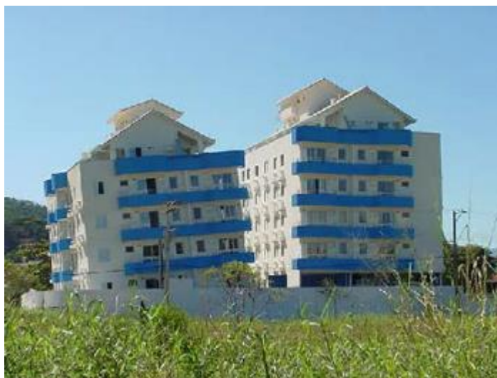
Figura 23 - Desaprumo de edifícios do condomínio Anêmona, em Ubatuba - SP
