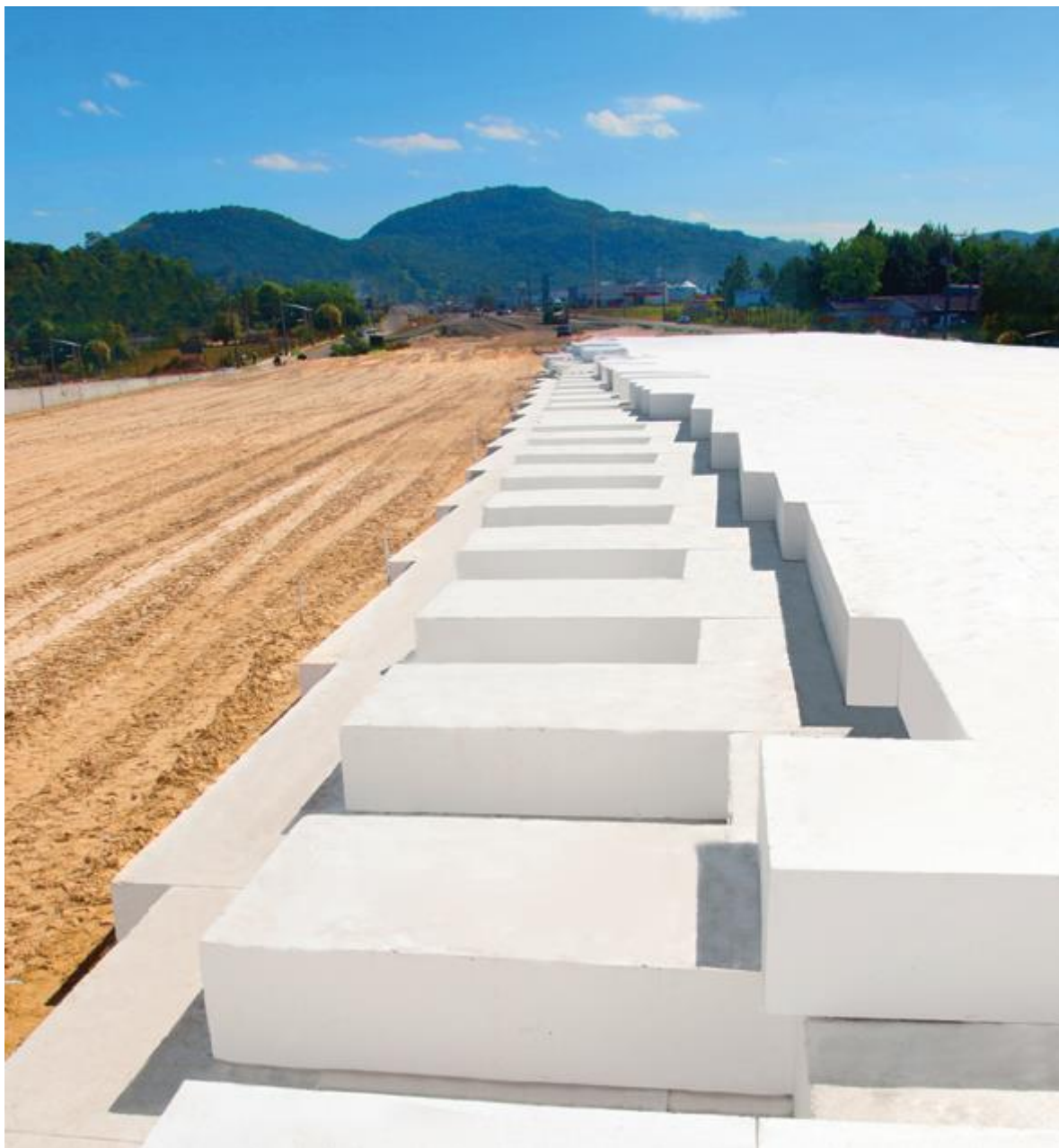
Figura 31 - Blocos de EPS armazenados em obra
